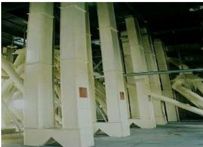
Система ковшового элеватора
